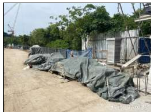
ภาพที่ 8 ใช้ผ้าใบปิดคลุมวัสดุก่อสร้าง
