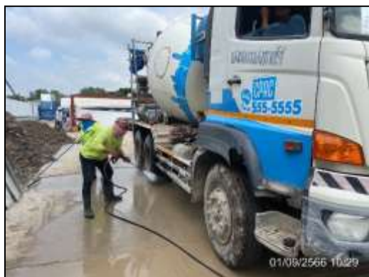
ภาพที่ 10 กิจกรรมทำความสะอาดล้อรถก่อนเข้าโครงการ
