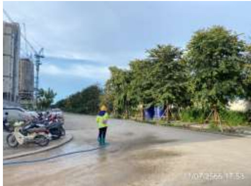
ภาพที่ 6 (ต่อ) ฉีดพรมน้ำบริเวณพื้นที่โครงการลดฝุ่น
