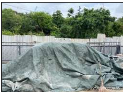
ภาพที่ 8 ใช้ผ้าใบปิดคลุมวัสดุก่อสร้าง
