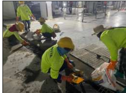
ภาพที่ 25 ขุดลอกรางระบายน้ำ
